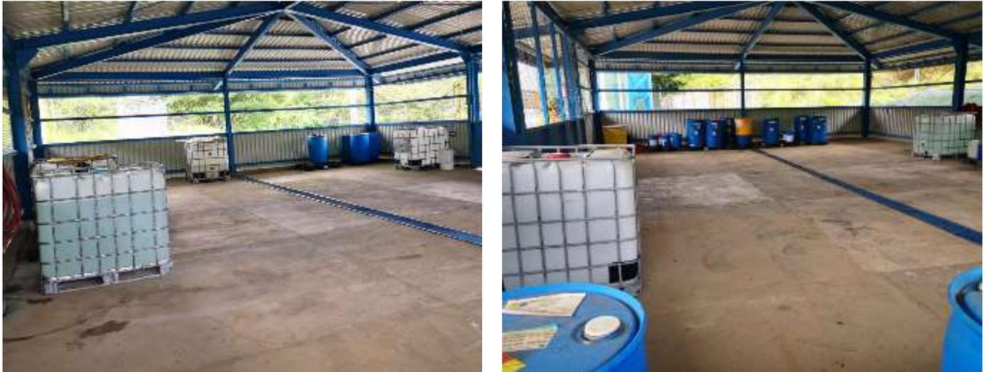
Figura 23 Almacén de sustancias peligrosas Unidad II, se cuenta con kits para el control de derrames y drenajes hacia el tanque de neutralización
