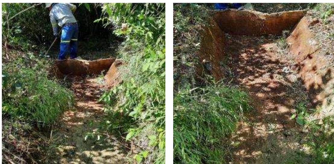
Figura 48. Limpieza de sedimentadores durante inspección de sistemas de evacuación pluvial. Campo Geotérmico Las Pailas. Enero, 2021.
