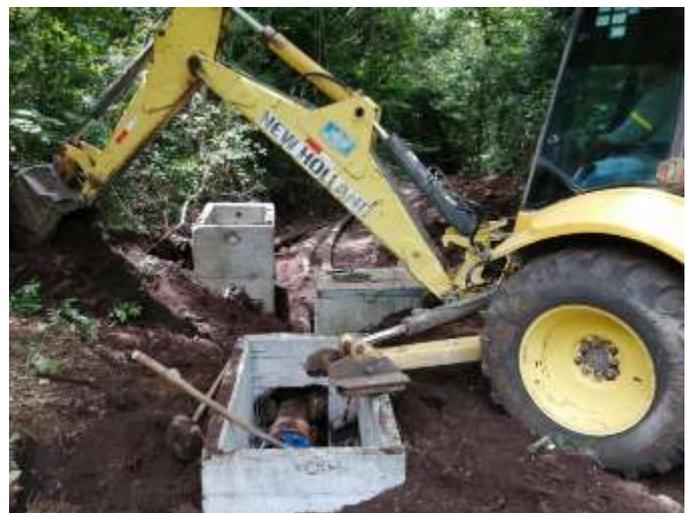
Figura 32 Instalación de hidrómetros en tubería que alimenta el Sistema contra incendio y agua cruda de Planta
