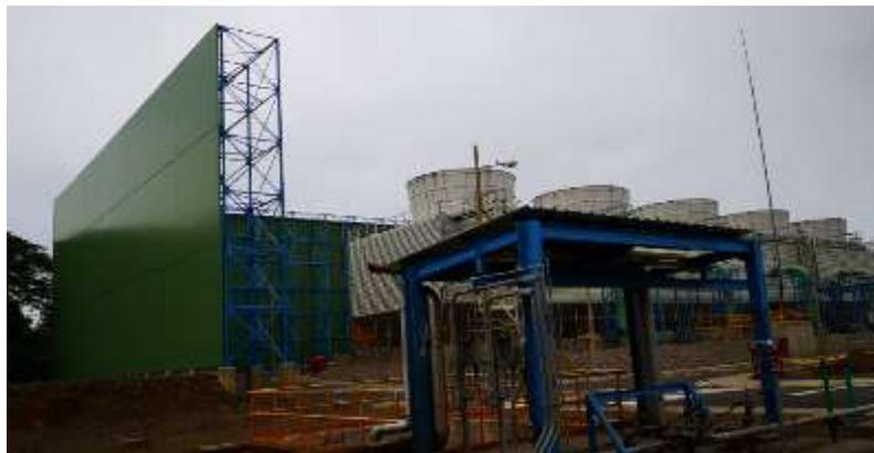
Figura 44 Pantalla sónica instalada en Planta Pailas Unidad II
