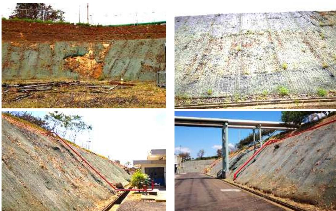
Figura 76 Estado estable de los taludes en Unidad I, sin embargo la geomembrana se encuentra deteriorada
