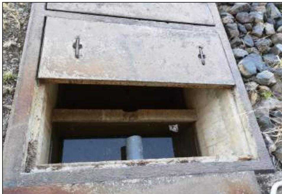
Figura 18 Tanque de neutralización de sustancias peligrosas
