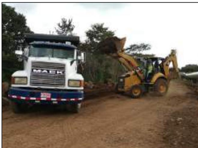
Figura 83. Retiro de material de las excavaciones para pedestales de la ruta.
