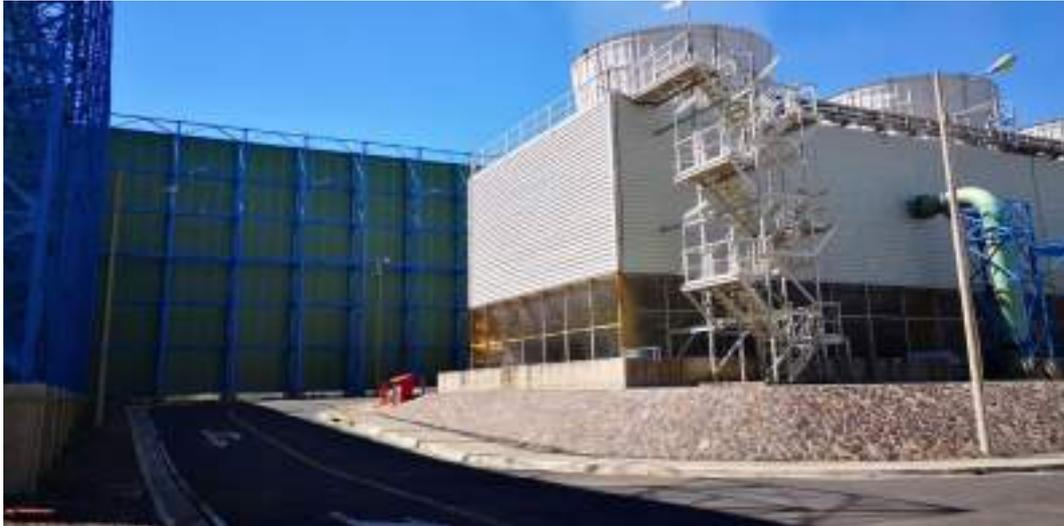
Figura 47 Pantalla sónica instalada en Planta Pailas Unidad II
