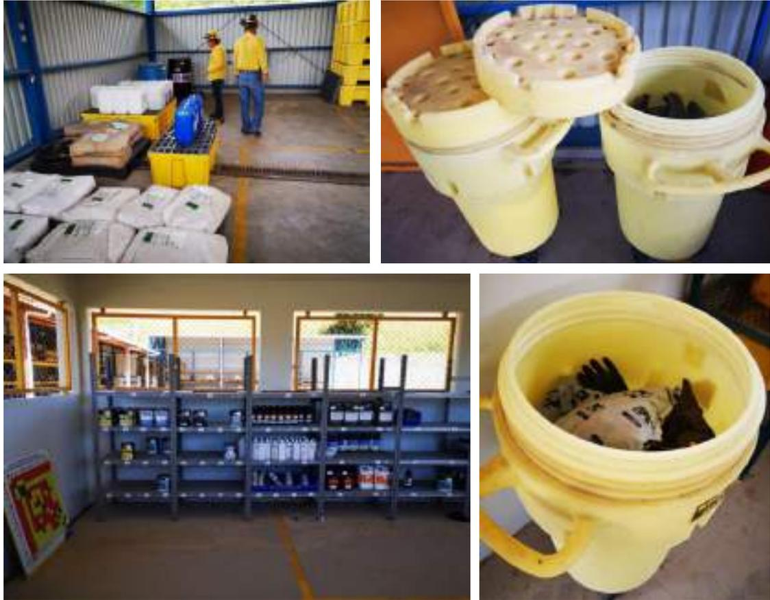
Figura 27 Almacén de sustancias peligrosas Unidad I, se cuenta con kits para el control de derrames y drenajes hacia el tanque de neutralización
