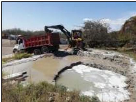
Figura 91. Limpieza de sedimentador de la planta de concreto.
