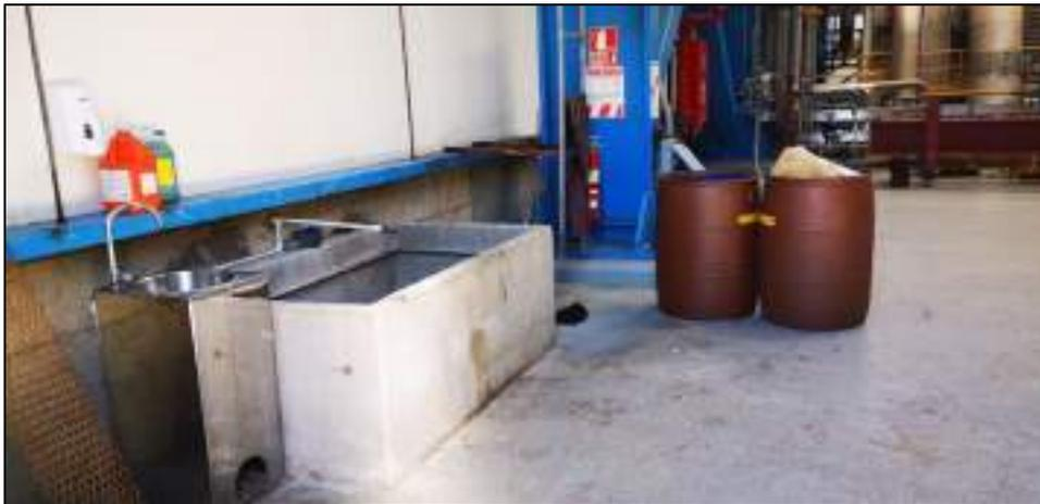
Figura 17 Pileta para el lavado de equipos mecánicos en Unidad II
