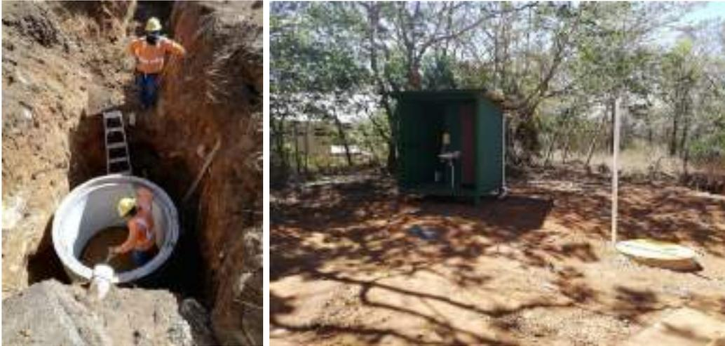
Figura 22. Construcción y uso de tanque séptico para la disposición de aguas residuales ordinarias.
