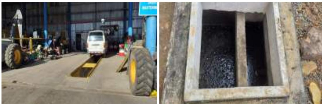
Figura 19. Taller mecánico con sus respectivos canales y trampas de aceites.
