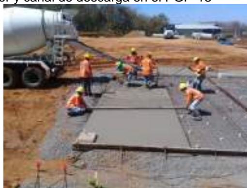
Construcción de fundación y losa de piso del edificio de Instrumentación y Control
