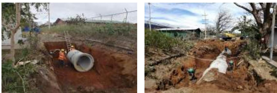
Figura 6 Construcción de sistema de alcantarillado para el drenaje de aguas pluviales
