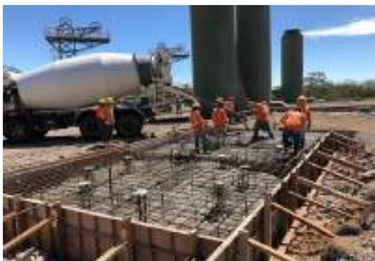
Construcción de cimiento de silenciador y canal de descarga en el PGP-13
