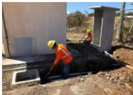
Colocación de tubería y caja de registro para automatización de pozos
