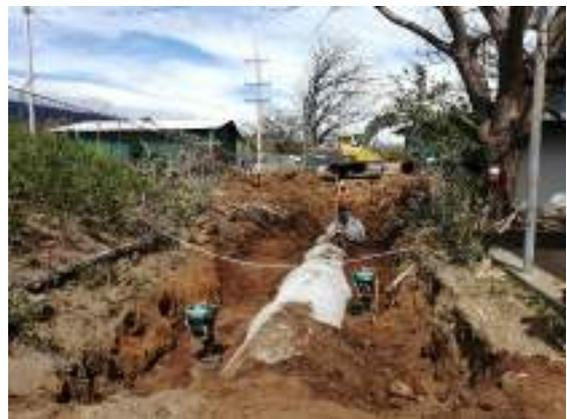
Figura 16. Proceso de conformación de taludes y construcción de alcantarillado para manejo de aguas pluviales.
