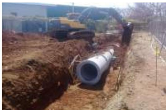
Construcción de sistema de recolección de aguas pluviales.
