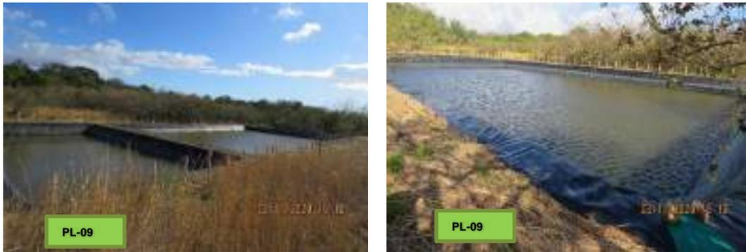
Figura 3. Lagunas impermeabilizadas en el campo geotérmico.
