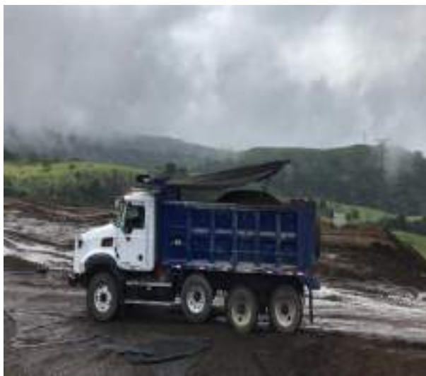
Figura 116. Circulación de vagoneta con el respectivo cobertor, marzo, 2021.
