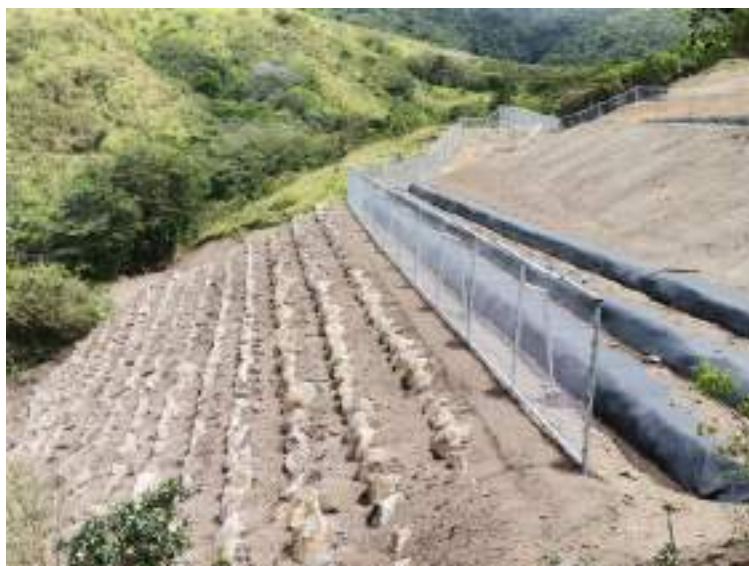
Figura 53. Construcción de dique de piedras para evitar daños a la vegetación por erosión o derrumbe en la PLB-05.
