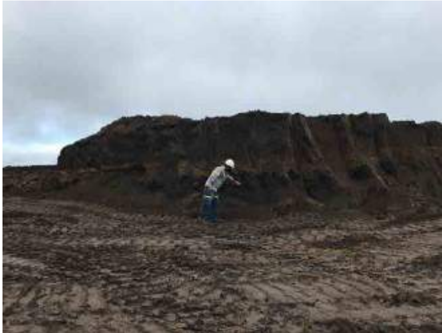
Figura 136. Revisión de perfiles estratigráficos en la obra Laguna de almacenamiento de agua de trabajo.
