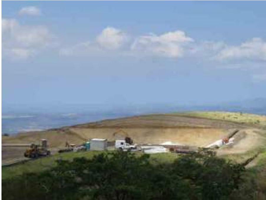
Vista panorámica sitio de obra Laguna de almacenamiento de agua de trabajo. Marzo 2021.
