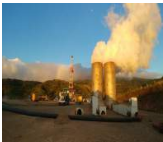
Figura 26. Sistema de silenciador.
