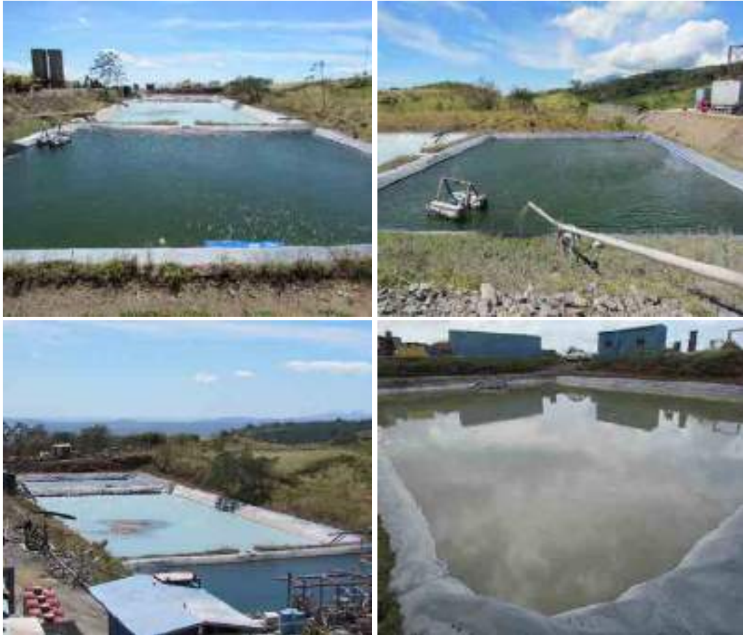
Figura 34. Lagunas impermeabilizadas en PLB-02.
