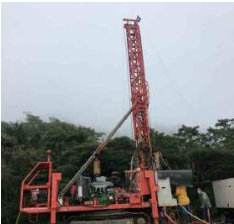
Figura 155. Pozos para extracción de agua.
