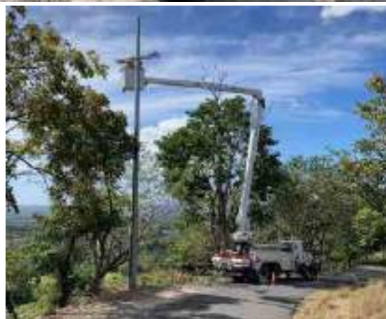
Figura 153. Construcción de la LD.
