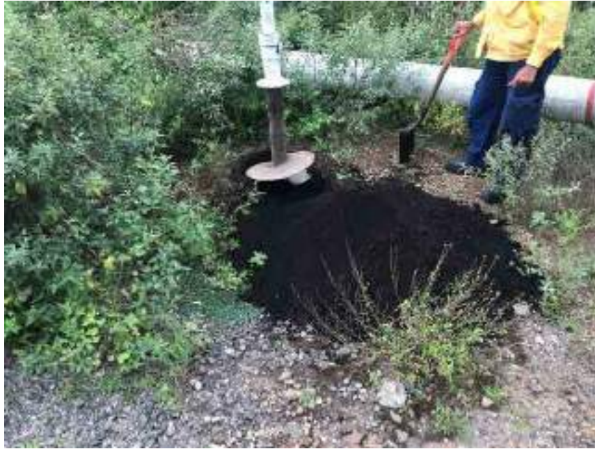
Figura 129. Excavación de hoyo para colocación de poste, Línea de Distribución trifásico.
