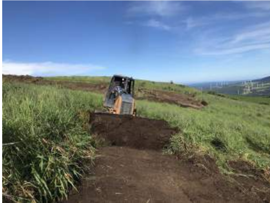
Figura 134. Remoción de cobertura vegetal en Laguna de almacenamiento de agua de trabajo.
