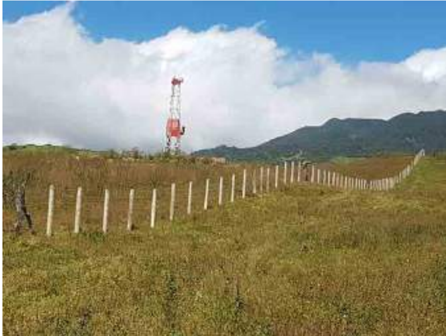
Proceso de construcción de cerca perimetral. Marzo 2021.
