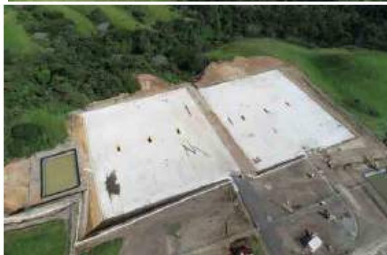
Figura 146. Construcción de Plazoleta PLB-08.
