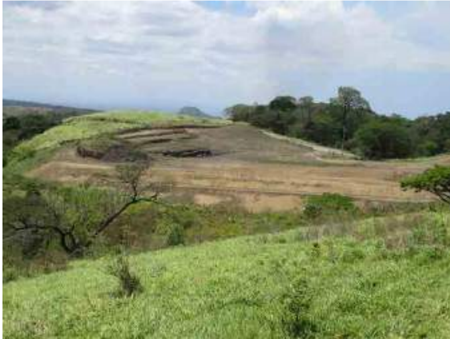
Vista panorámica del sitio de obra Escombrera 2. Marzo 2021.
