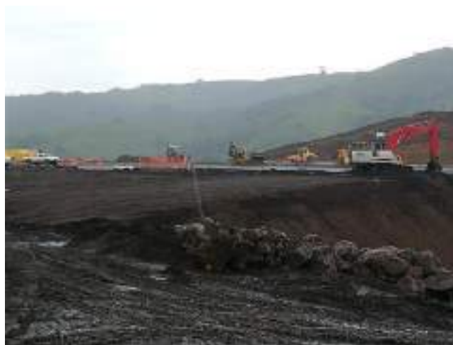
Figura 28. Mantenimiento y estabilización de taludes en la PLB-02.
