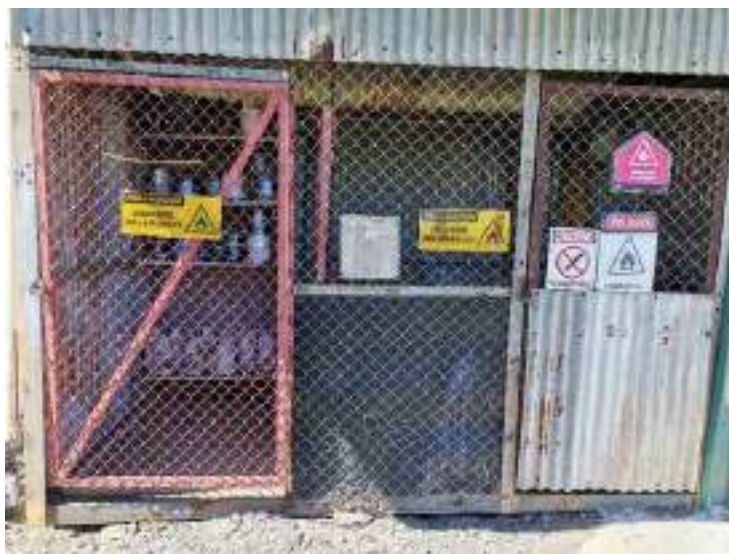
Figura 72. Habilitación de caseta para almacenamiento de residuos peligrosos.
