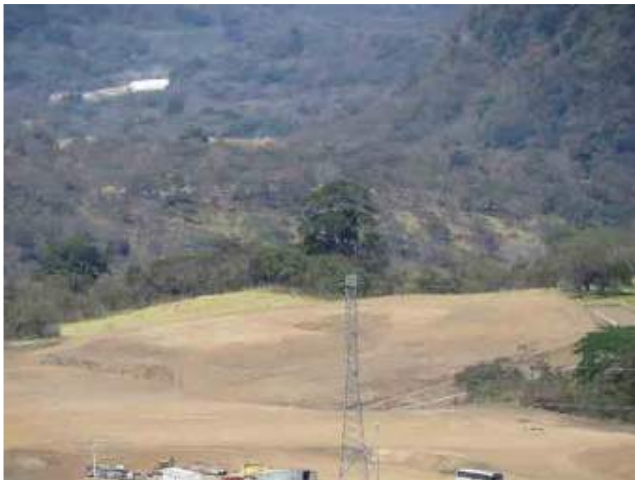
Sitio de obra Escombrera 1. Marzo 2021.
