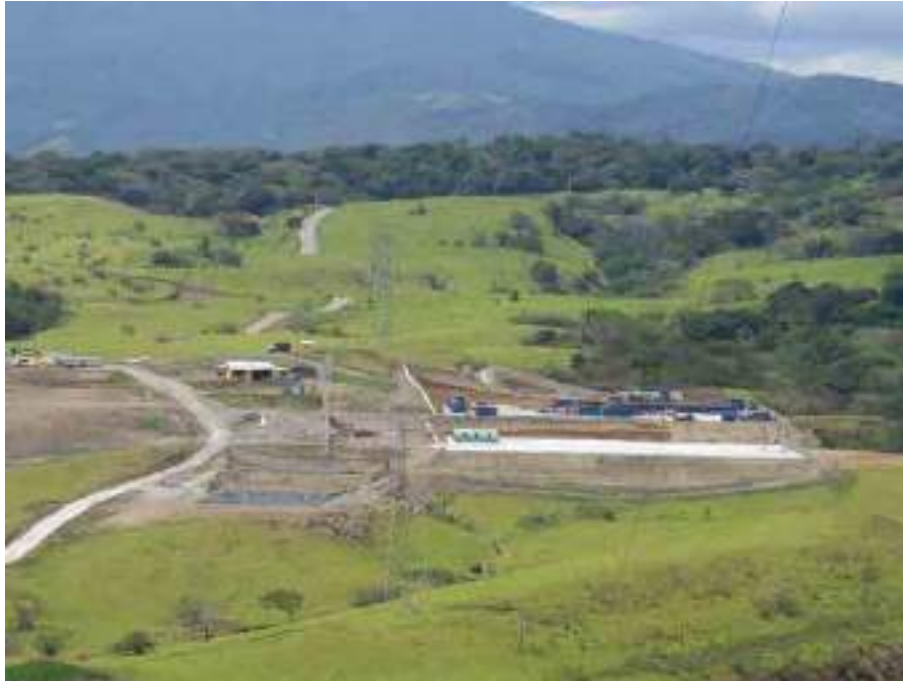
Vista panorámica del sitio de obra Plazoleta PLB-08. Marzo 2021.
