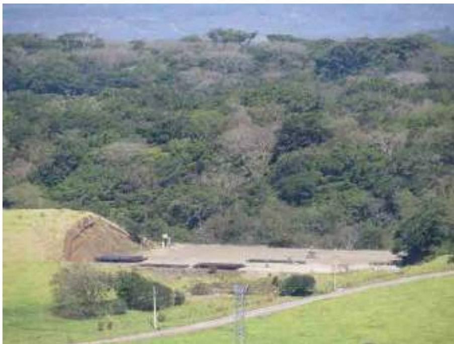
Vista panorámica del sitio de obra Plazoleta PLB-09. Marzo 2021.
