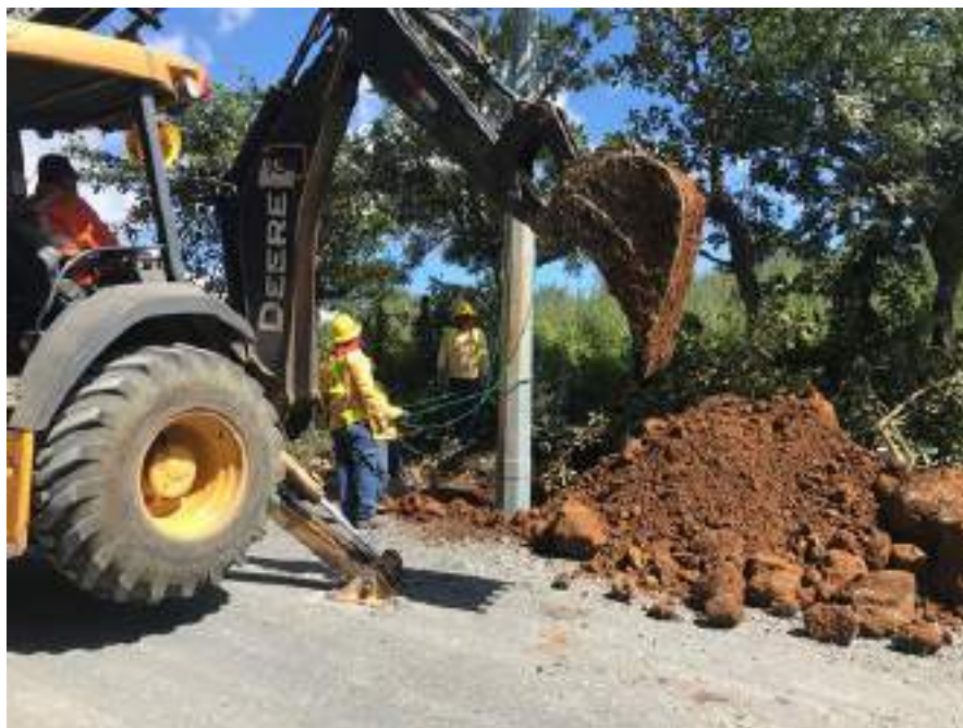
Figura 131. Excavación de pozo con back hoe cercano al sitio arqueológico G-954 OI.
