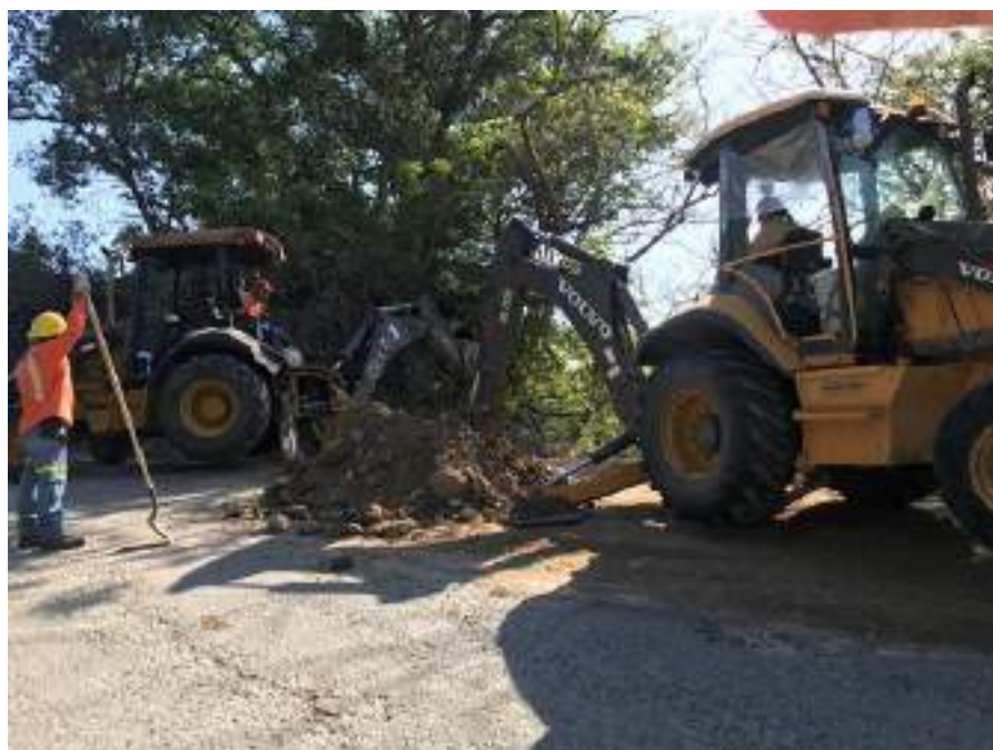
Figura 132. Excavación de pozo auto soportante (sin anclaje) en las cercanías del río Tizate.
