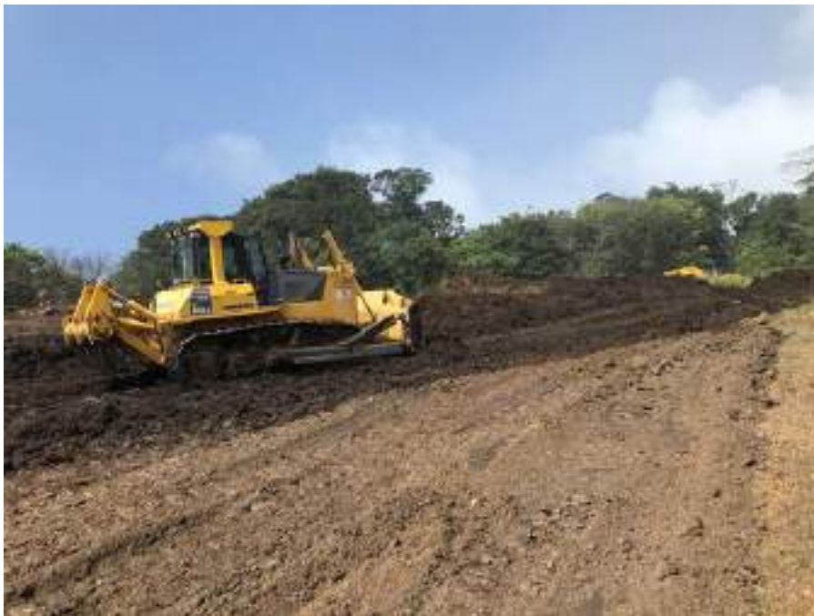
Figura 140. Supervisión en el sector norte de la escombrera.
