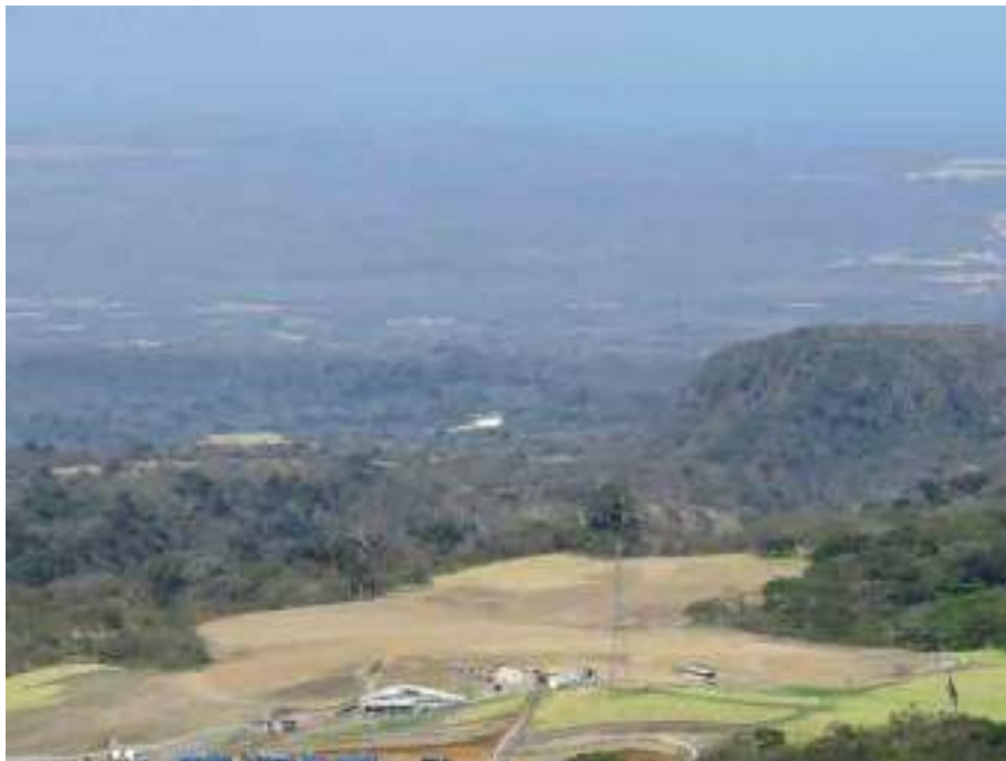
Vista panorámica sitio de obra Escombrera 1. Marzo 2021.
