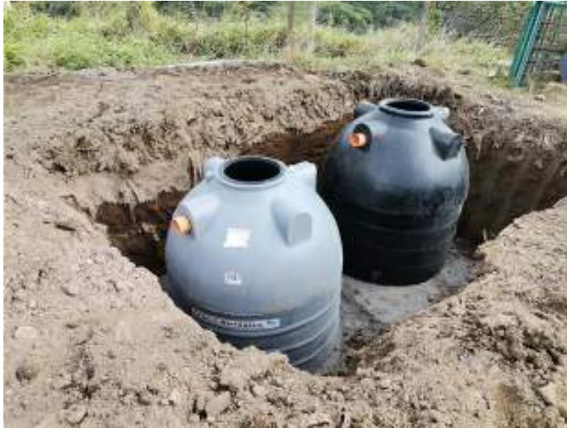
Figura 38. Construcción de tanque séptico en la PGB-05.
