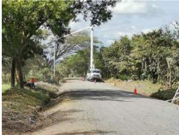
Figura 145. Demarcación y regulación de tránsito en los sitios de trabajo de la LD.
