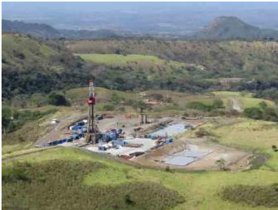
Vista panorámica del sitio de obra Plazoleta PLB-02. Marzo 2021.
