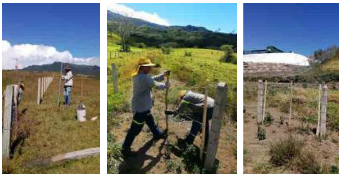
Figura 62. Construcción de cerca perimetral del Campo Geotérmico Borinquen.
