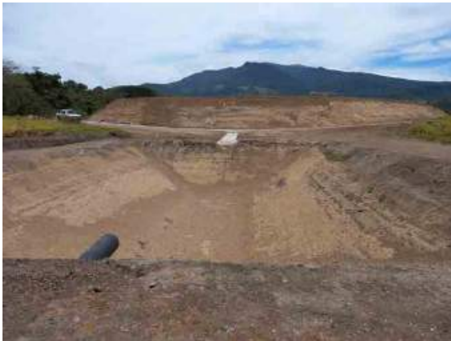
Sedimentador de la Escombrera 1. Marzo 2021.
