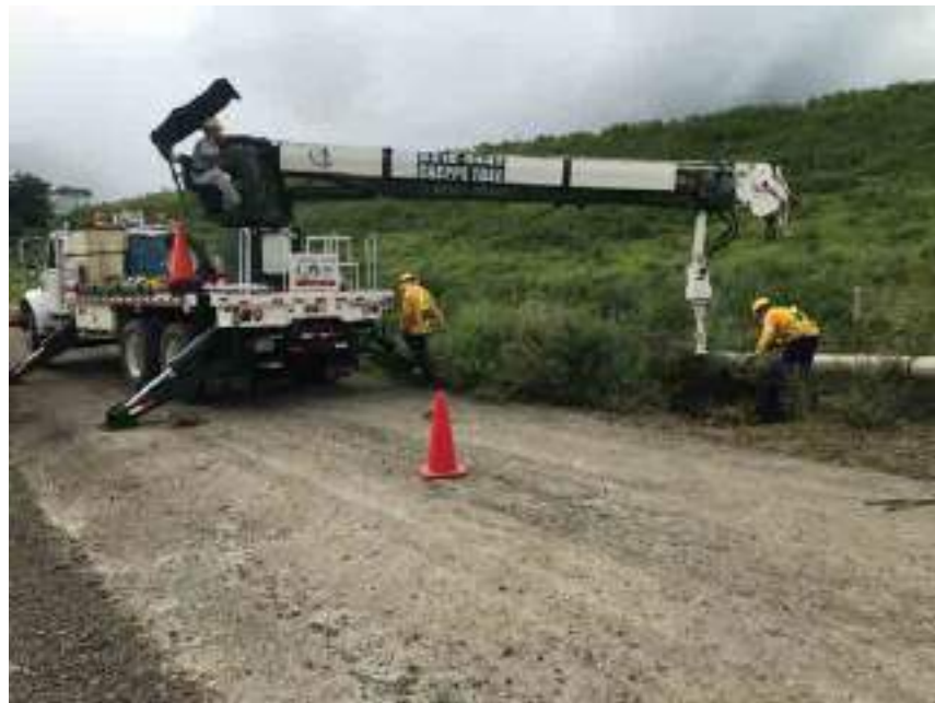
Figura 130. Máquina excavadora de pozo para la colocación de postes de la Línea de Distribución trifásica.
