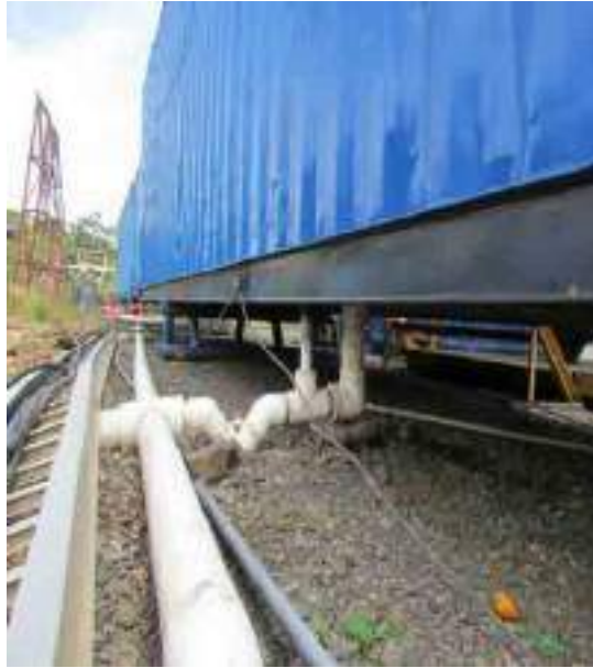
Figura 37. Manejo de aguas ordinarias en sitios de perforación.
