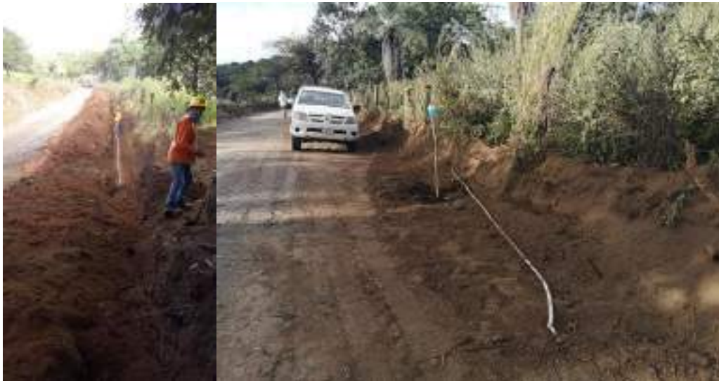
Figura 143. Reparación de tubería en los trabajos de la LT.
