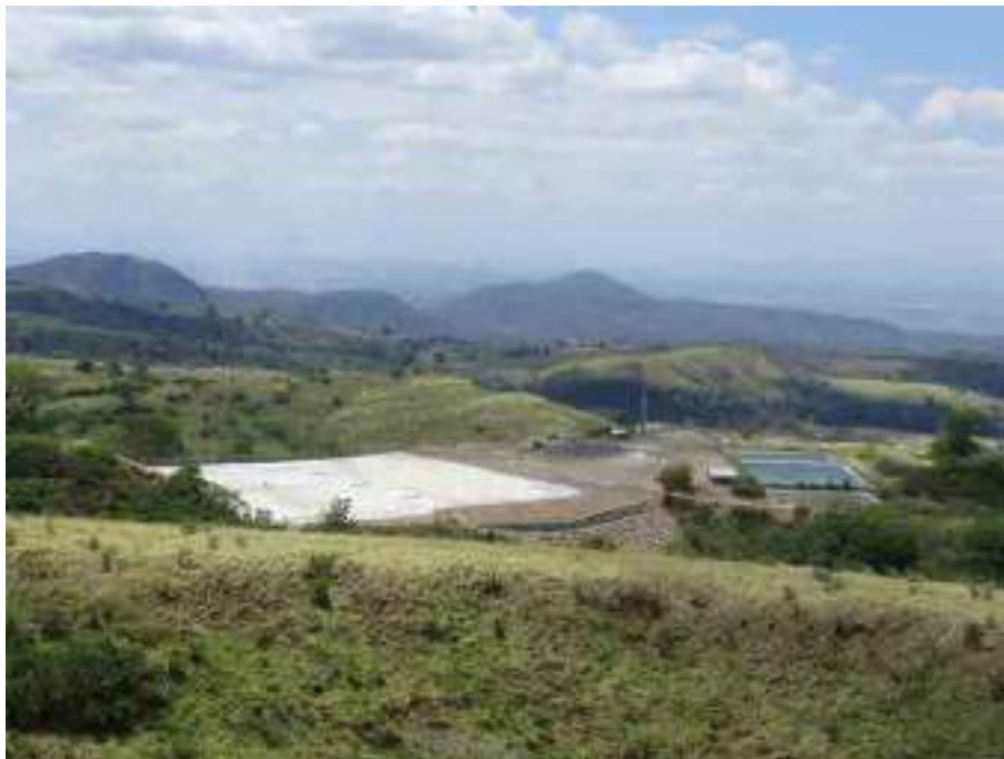
Vista panorámica del sitio de obra Plazoleta PLB-05. Al fondo se observa la Plazoleta PLB-02. Marzo 2021.
