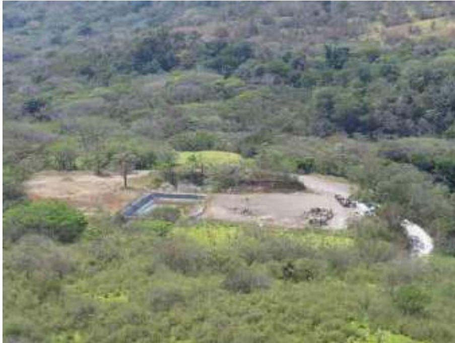
Vista panorámica del sitio de obra Plazoleta PLB-03. Marzo 2021.
