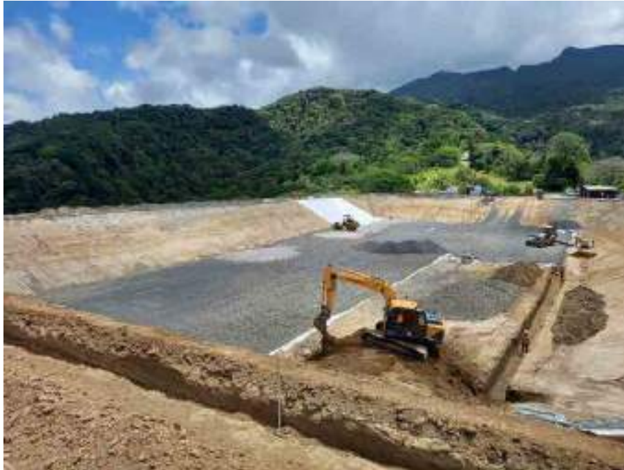
Proceso de excavación y movimiento de tierra para la construcción de la Laguna de almacenamiento LGB-05. Marzo 2021.
