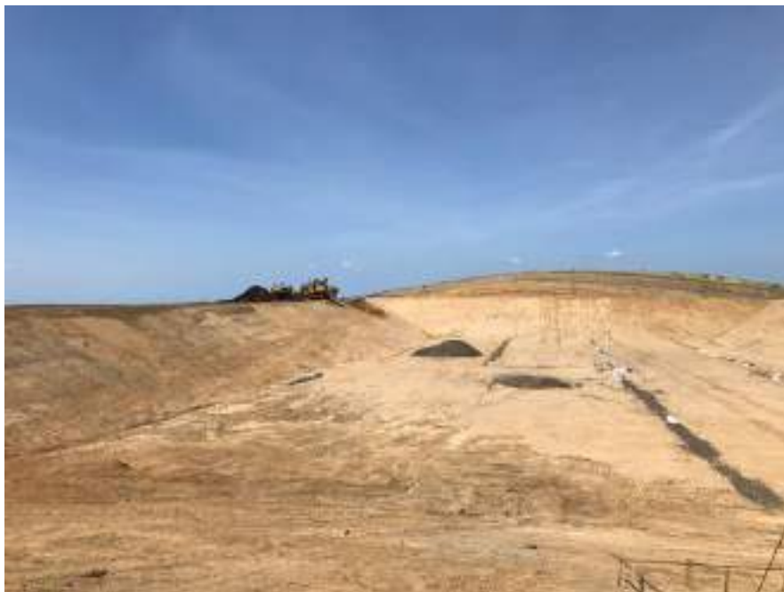
Figura 137. Finalización de movimientos de tierra en la obra Laguna de almacenamiento de agua de trabajo.
