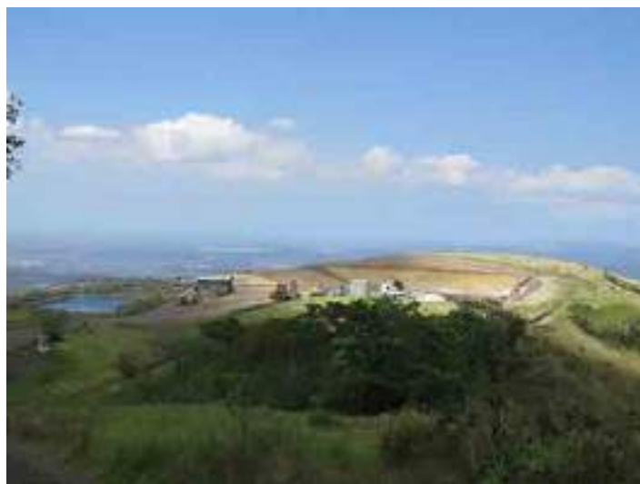
Figura 141. Laguna de almacenamiento, 2021.
