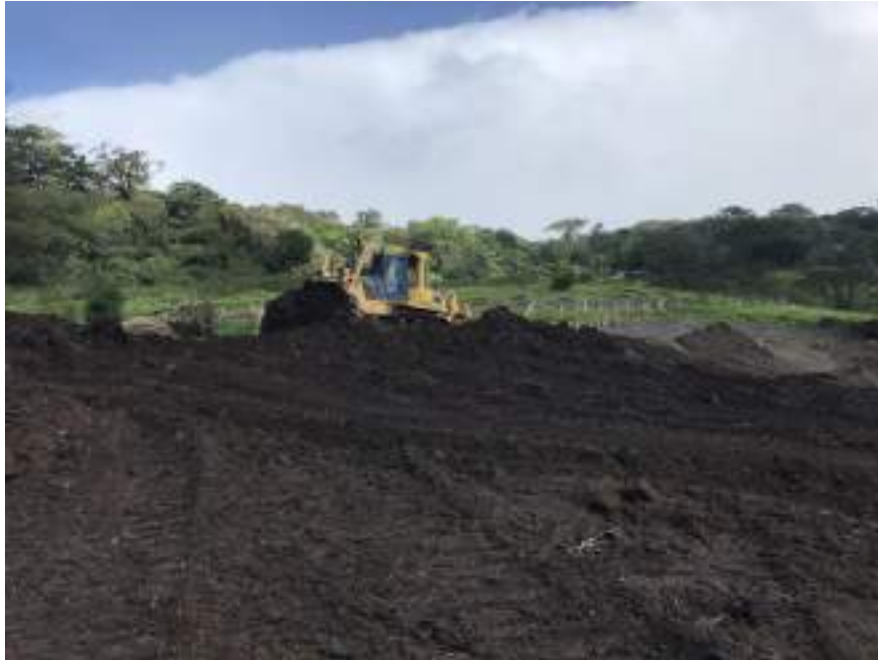
Figura 139. Supervisión en el sector suroeste de la escombrera.
