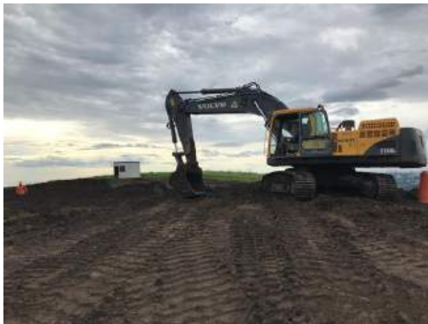
Figura 135. Corte con retroexcavadora para preparación de talud y posterior nivelación del terreno.
